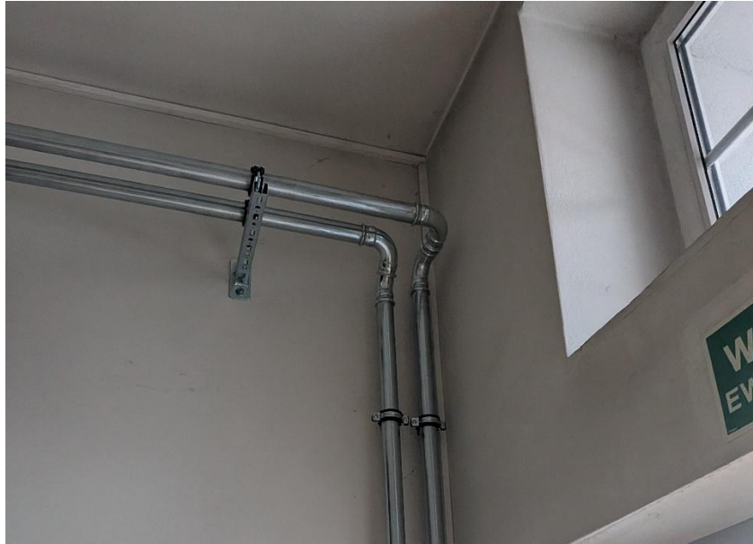
Nowa instalacja centralnego ogrzewania w budynku warsztatowo-technicznym
