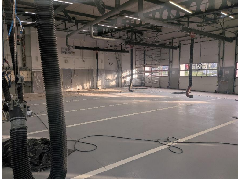
Garaż JRG Chrzanów przed oraz w trakcie remontu
