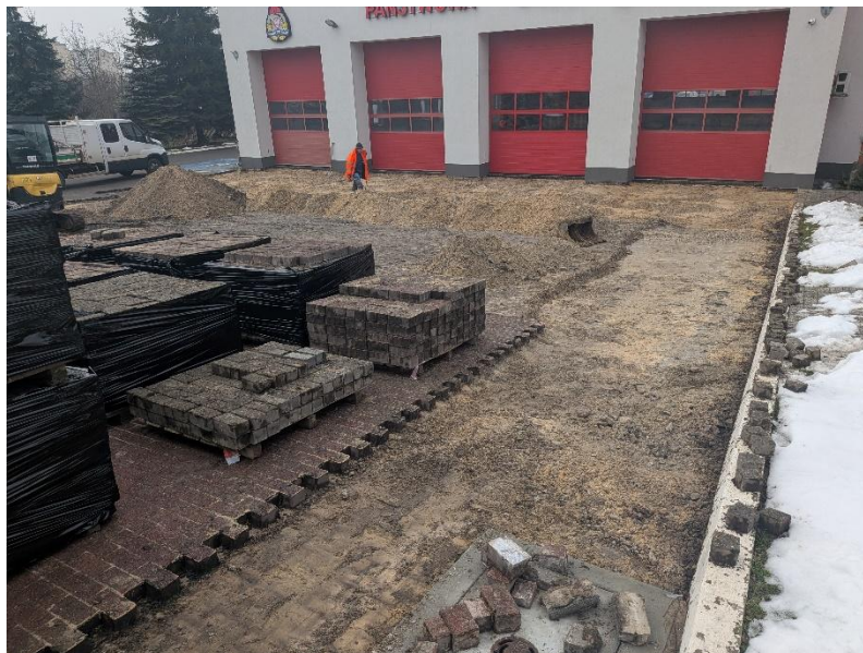
Plac przed garażem JRG w czasie remontu
