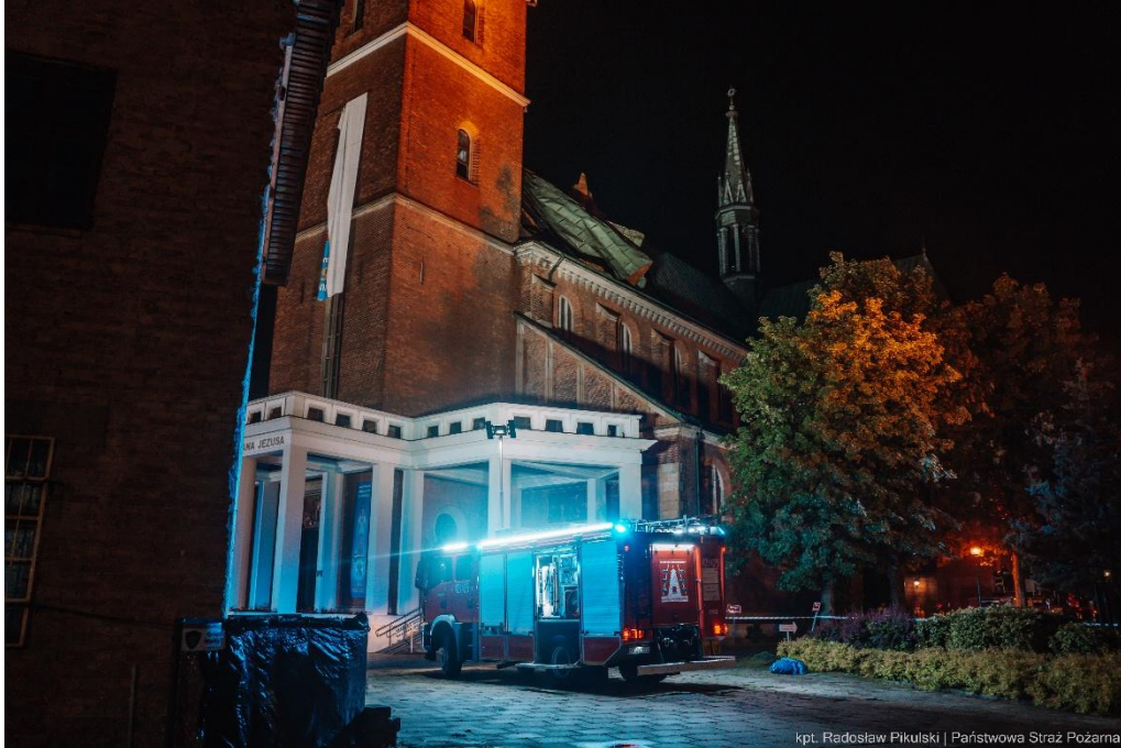
Uszkodzony dach w Bazylice Mniejszej NSPJ w Trzebini – 05.06.2025 r.
